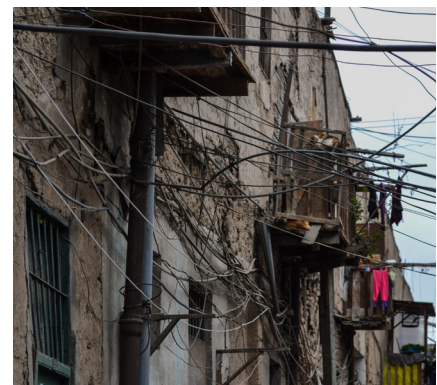
Figura 11: La gestión de riesgos y políticas públicas de protección del Centro Histórico tiene que ir más allá de las fachadas y facilitar estrategias de recuperación de las viviendas tugurizadas y en estado de deterioro. Foto: T. Belkow.
